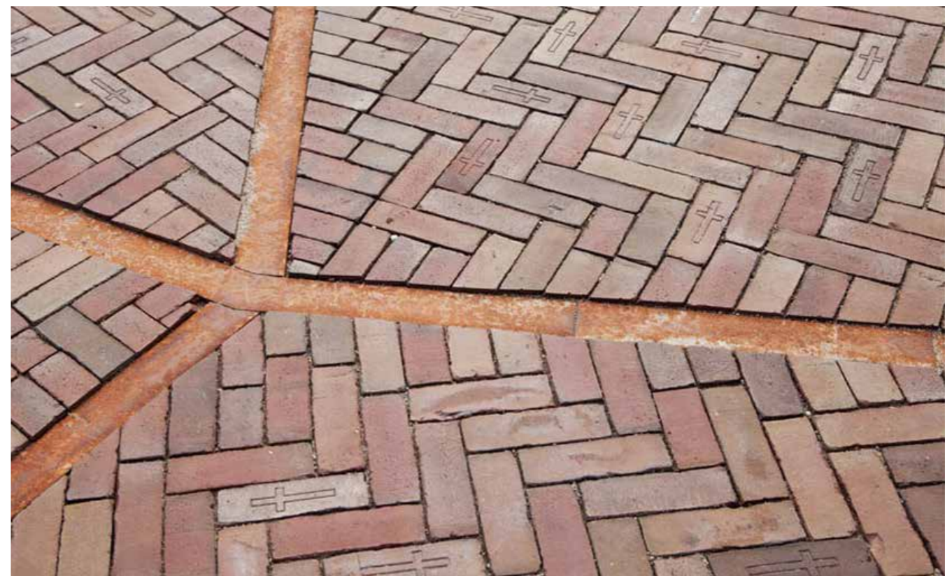
Cortenstalen strip in de bestrating voorzien van twee strekken kasseien.
