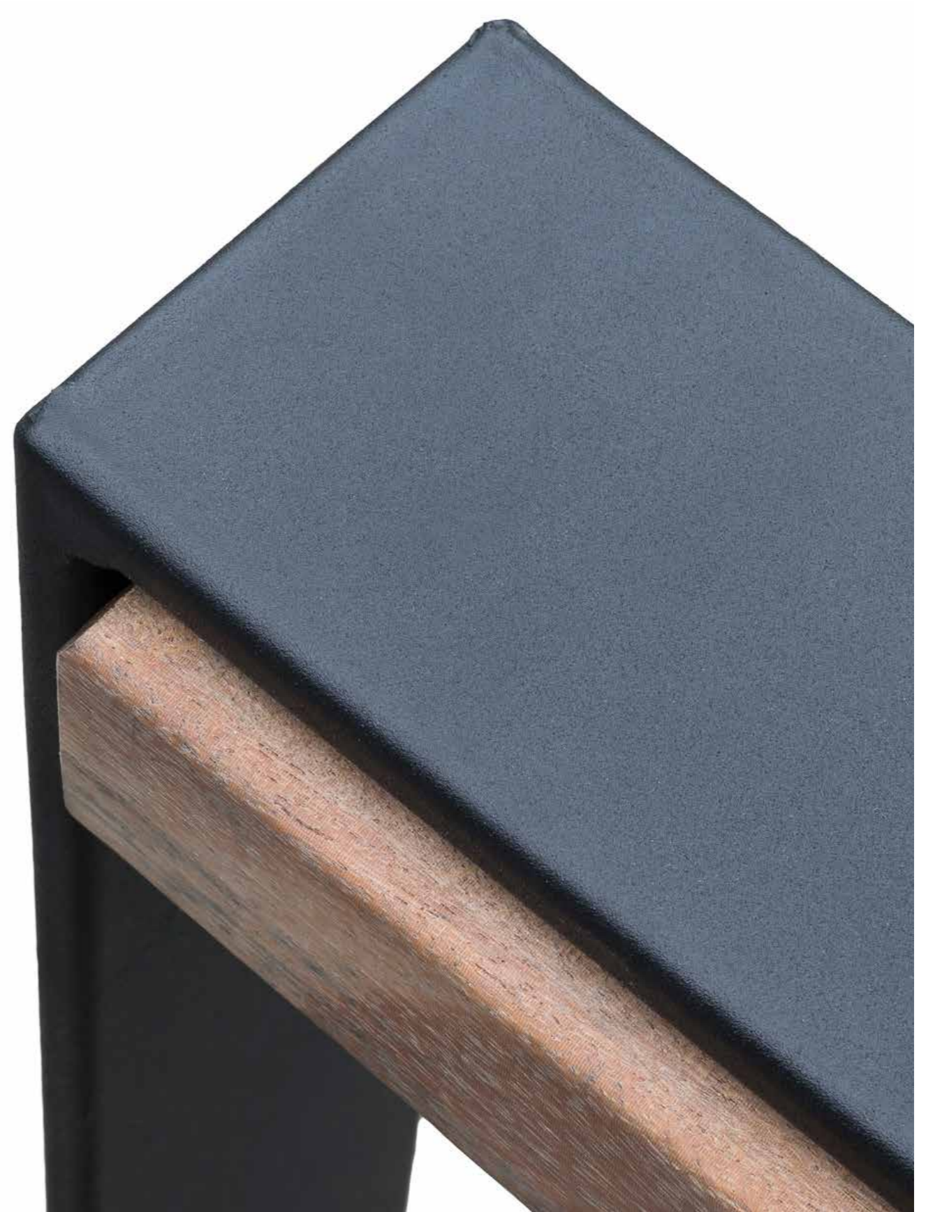
Fietsbeugels met een houten detail, voorkomt schade aan fiets en beugel.
